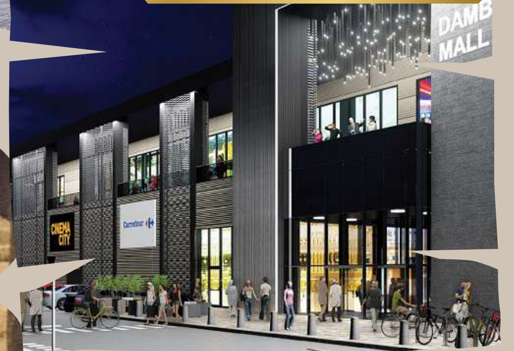
Dambovită Mall Shopping Center
